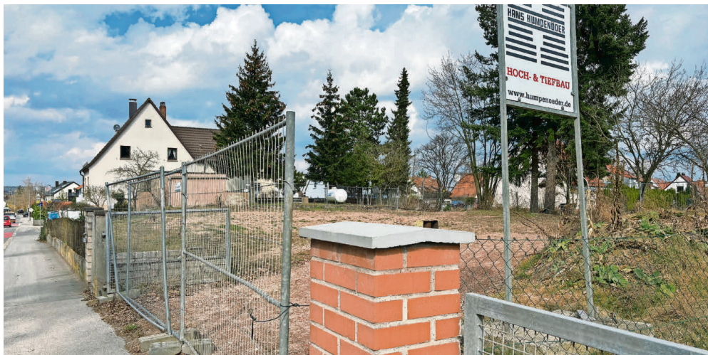
In der Äußeren Rittersbacher Straße 21 in Schwabach hätte eigentlich ein Mehrfamilienhaus entstehen sollen.
