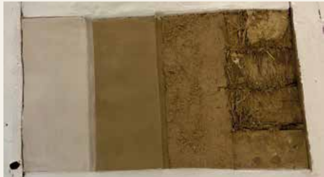
Ein Zeitfenster bietet den Einblick in den Deckenaufbau.
