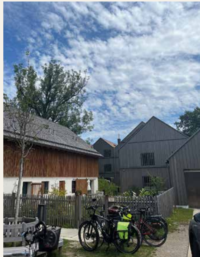
Der Neubau ordnet sich dem Bauernhaus (vorne links) unter.
