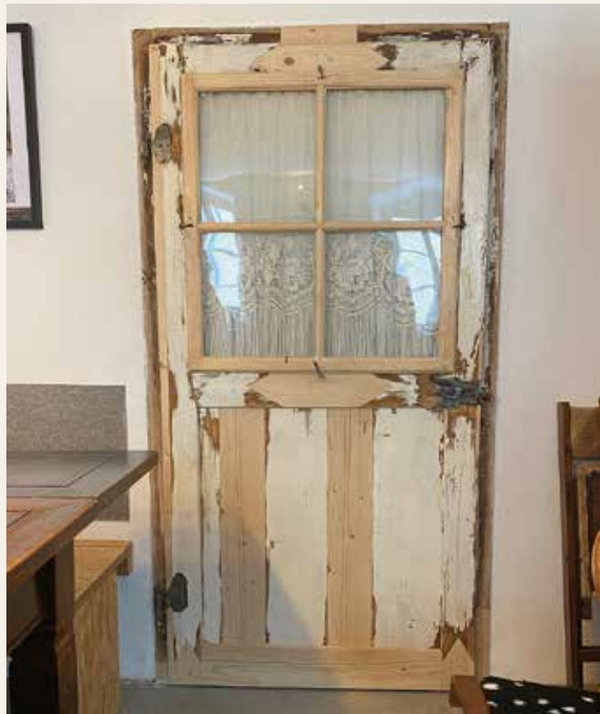
Die alte Tür wurde erhalten und mit neuem Holz verbreitert.
