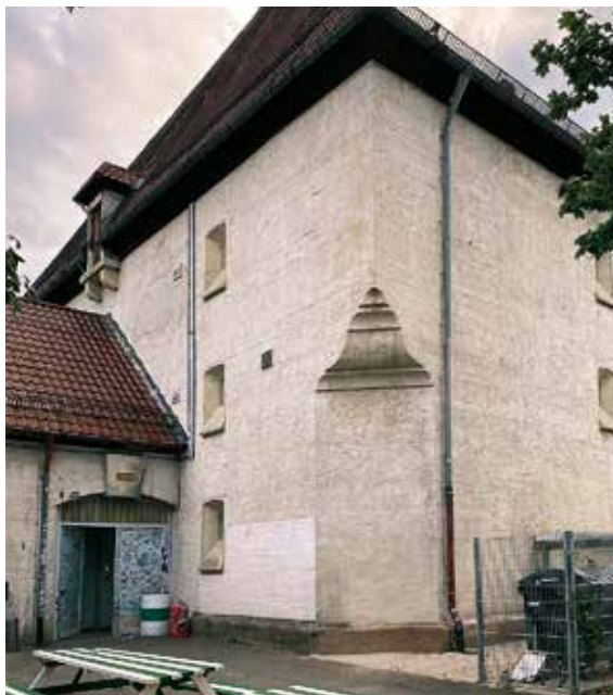
Der Bunker ist nicht auf den ersten Blick als solcher zu erkennen. Die Massivität ist aber zu erahnen.
