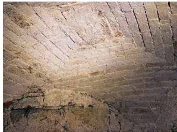
Wände aus Naturstein und Decken kunstvoll und tragfähig gemauert aus Backsteinen - so stellen sich die Keller dar.
