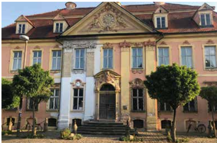
Das Gilardihaus ist eine repräsentative Villa einer wohlhabenden Fabrikantenfamilie. Die Produktionshallen befanden sich, wie in der Übergangszeit zur Industrialisierung üblich, direkt hinter der Villa. – Gut erkennbar sind die unterschiedlichen Versuche zur Fassadengestaltung im Rahmen der Sanierung.
