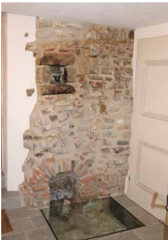
Der Heizofen war das sichere Indiz, dass es sich bei diesem Gebäude um das ehemalige Badhaus handelt.
